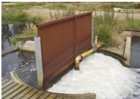
Joonis 2.12. Õhktõstukiga aereerimissüsteem.
