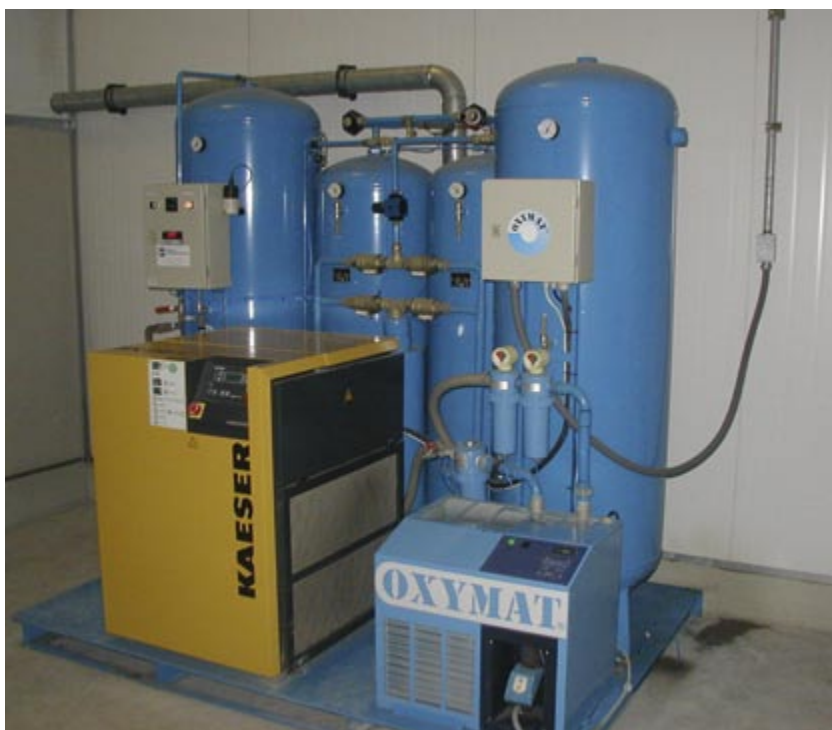
Joonis 5.2. Hapnikugeneraatori peab paigaldama ja seda peab jälgima spetsialist
