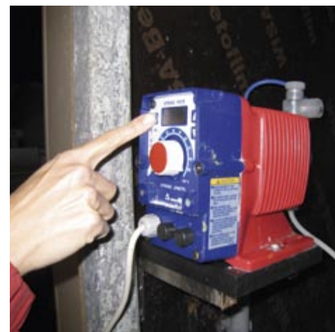
Joonis 2.16. pH reguleerimiseks kasutatav doseerimispump, mis viib NaOH süsteemi. Pump võib olla ühendatud pH-sensoriga, mis tagab täisautomaatse pH reguleerimise.
